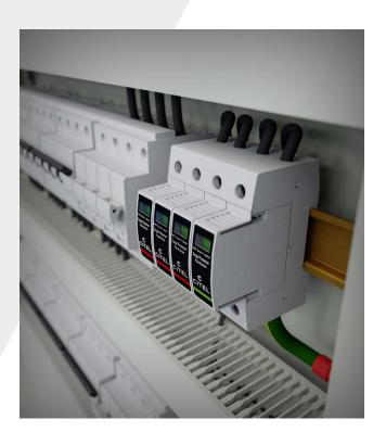
La gamme CITEL de Parafoudres modulaires est conçue pour répondre à l'ensemble des besoins de protection des installations Basse Tension contre les surtensions d'origine foudre et industrielle.
